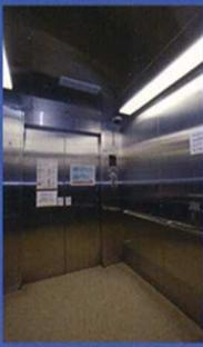
ダム堤体内部には2基のエレベータが設置されており、放流設備などの機器の交換や、点検等の維持管理に利用されています。そのうち1基のエレベータは、ダムの体験学習を目的として一般見学者も利用できます。
