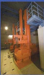
高位常用洪水吐設備はダム堤体を上下流方向に貫通する二本の放流管路の途中にあります。ダム水圧に耐えられる頑丈なステンレス鋼の扉が油圧によって上下に動き、管路内の水を流したり止めたりしています。
