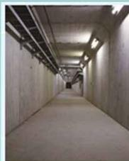
ダム堤体の内部に設けられた点検や観測のため通路です。宮ヶ瀬ダムを効率よく安全に管理・運営するための、さまざまな管理設備や計測機器の点検・観測に使用しています。
